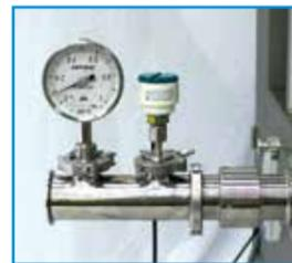
**定圧装置 (PID装置)・圧力計**
